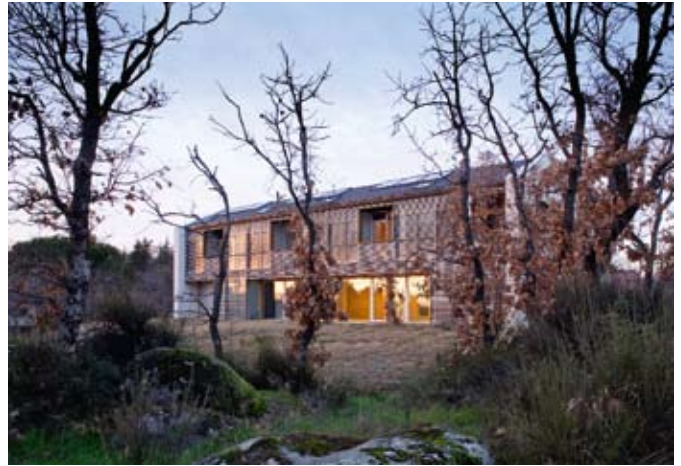
LA FACCIATA A SUD DELLA CASA FUJI È TRASPARENTE, CON UNA SCHERMATURA IN LAMELLE D'ALLUMINIO AL PRIMO PIANO, PER SFRUTTARE AL MASSIMO L'APPORTO DELL'ENERGIA SOLARE.
