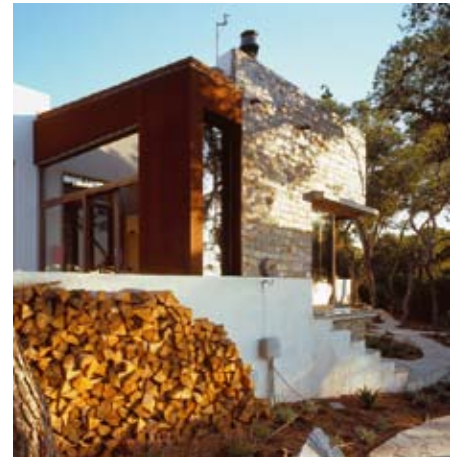
QUI SOPRA, L'ANGOLO DELLA CASA RIVOLTO VERSO IL MARE. IN ALTO, LA ZONA CONVIVIALE ALL'APERTO, CHE È ANCHE AREA GIOCO PER I BAMBINI.
