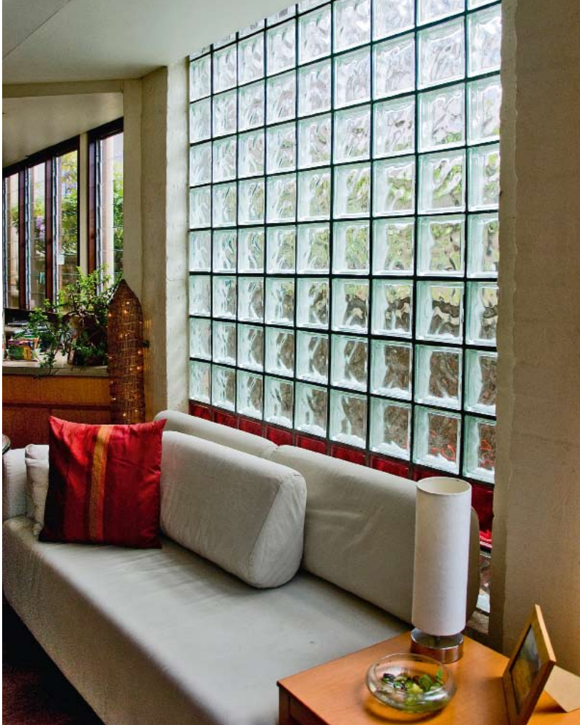
PARETI DI VETROMATTONI TERMOISOLANTE E FINESTRE BEN COIBENTATE AUMENTANO IL COMFORT E RIDUCONO GLI SPRECHI ENERGETICI.
