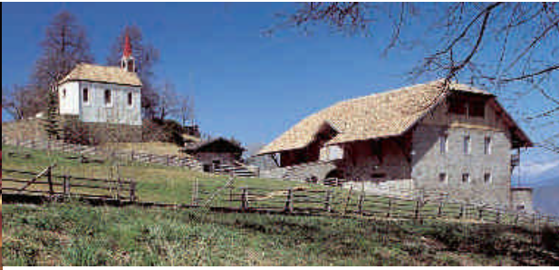
PROSPETTO E FOTO DEL CENTRO AMBIENTALE AL COLLE, REALIZZATO DA SASSO NEL 1995 PER IL COMUNE DI BOLZANO.
